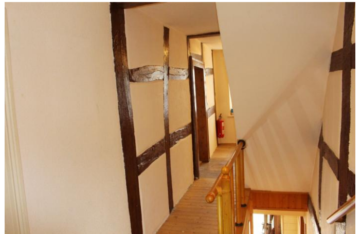
Flur im OG
