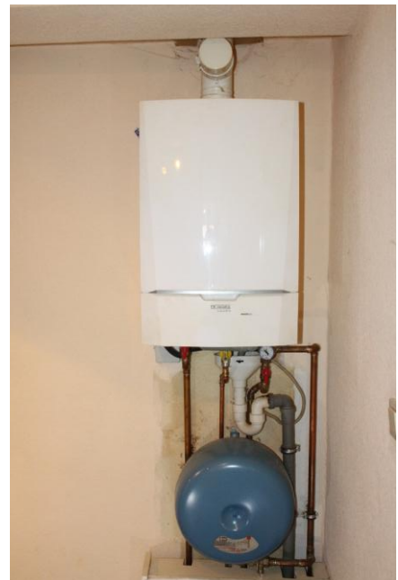
Gas-Brennwert-Wandheizkessel Baujahr 2015
